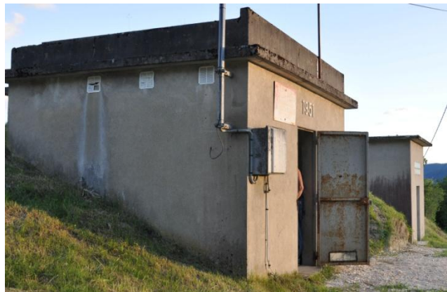
Les réservoirs d'eau, route du Colombier
