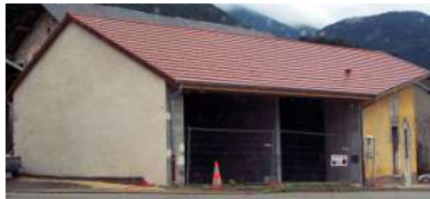
Le chantier de la maison Paget en 2008
