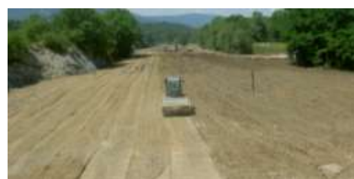
30 000 m 3 de terre argileuse recouvre le site
