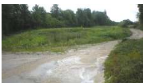
Entrée Nord avant travaux
